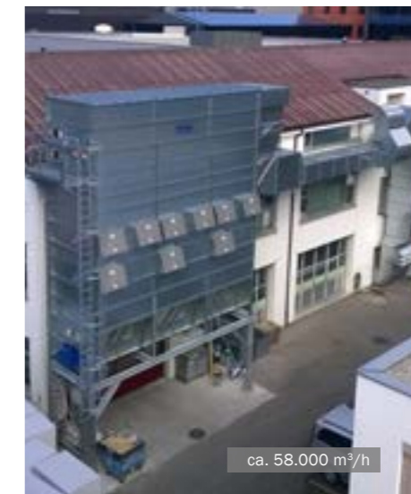
MultiStar filtrs ar gliemežtransportieri un gaisa recirkulāciju • Iekšējā izbūve
