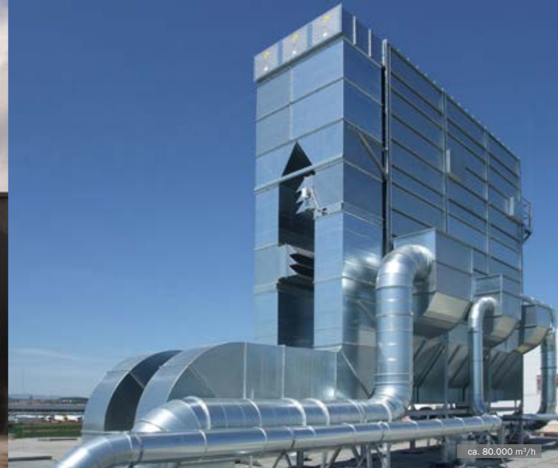
MultiStar filtrs ar gliemežtransportieri un gaisa recirkulācijas tīrīšanu • Sporta preču ražošana
