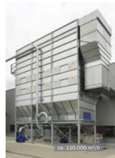
MultiStar filtrs ar gliemežtransportieri un gaisa recirkulāciju
