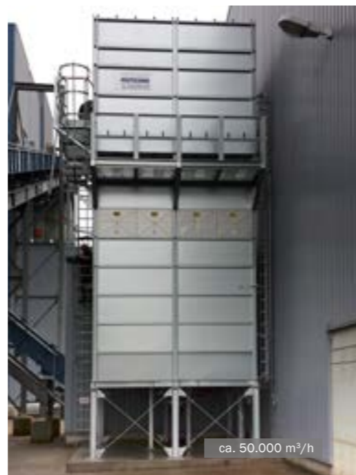
MultiStar filtri ar maisītāja mehānismu • Biomasas spēkstacija
